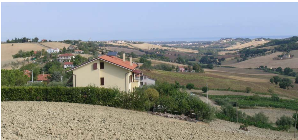
Foto A1 – L’edificazione nel crinale lungo la strada comunale da Agugliano a Camerata Picena
